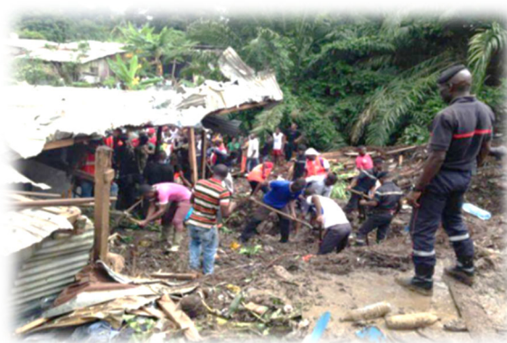
Photo 2 : Glissement de terrain à Mossikro (Commune d'Attécoubé) Source : APA
